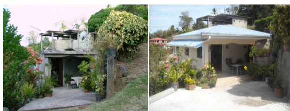
Avant et après la rénovation
