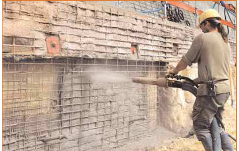
FIGURE 6 - Réalisation du parement par béton projeté.
