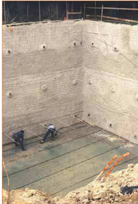
FIGURE 3 - Ouvrage neuf, paroi clouée en soutènement d'excavation.
